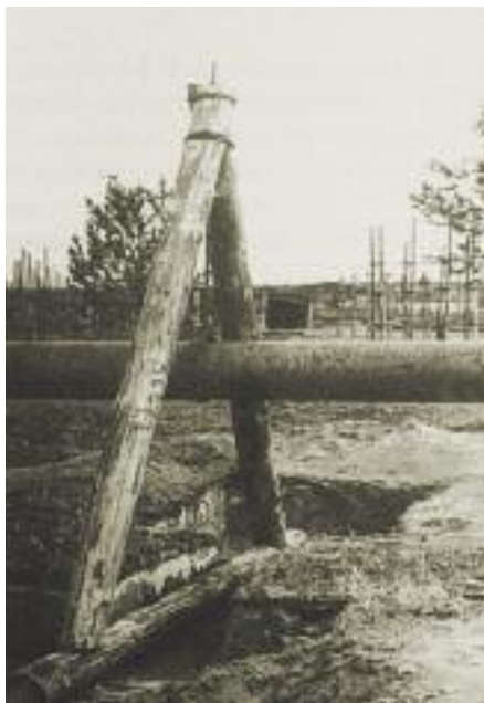
Фрагмент подвешенного трубопровода, Коми АССР
