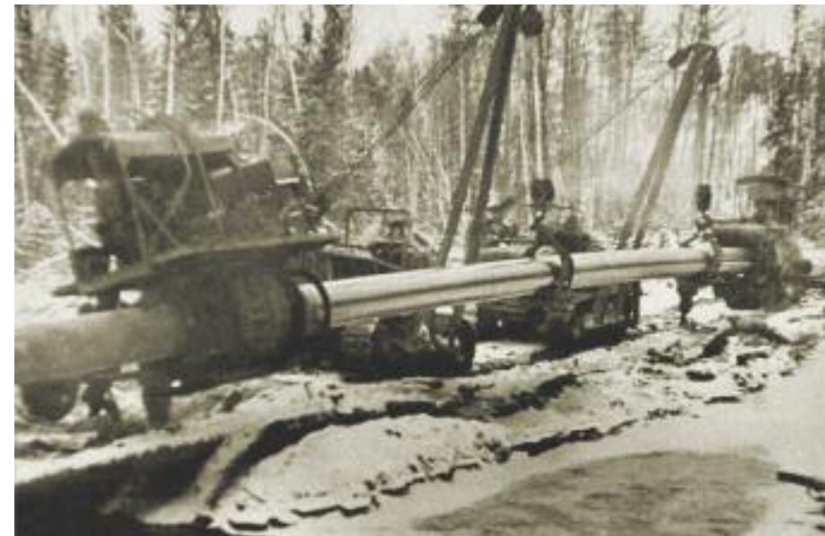
На трассе строительства магистрального нефтепровода Шаим – Тюмень
